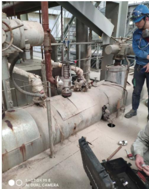
安全阀校验可通过三种方法进行：第一种就是校验台离线校验，就是将安全阀安装在校验台上，然后使用校验介质使安全阀开启，通过观察压力表来确认开启压力。这种方法无法考虑背压安全阀和高温或者低温介质的安全阀校验；第二种就是升压式跳法。就是安全阀在系统中安装，系统人为升压，直至安全阀起跳，来观察安全阀的开启压力，这种校验方法对安全阀的密封面损伤较大，操作危险性较大；第三种就是在线仪器校验。就是通过外力将作用在安全阀上向下的弹簧作用力测出，以此来计算出安全阀的开启压力，这种方法一般不影响生产、系统压力不用改变，
